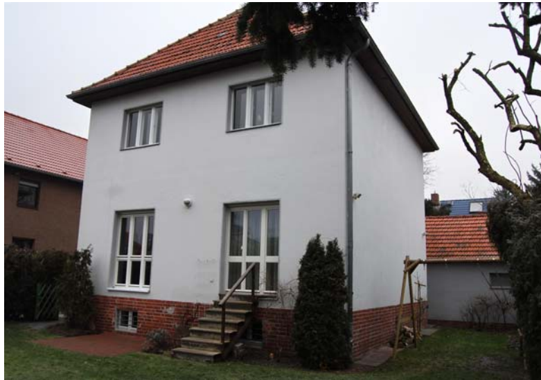
Vorderansicht vor dem Umbau
