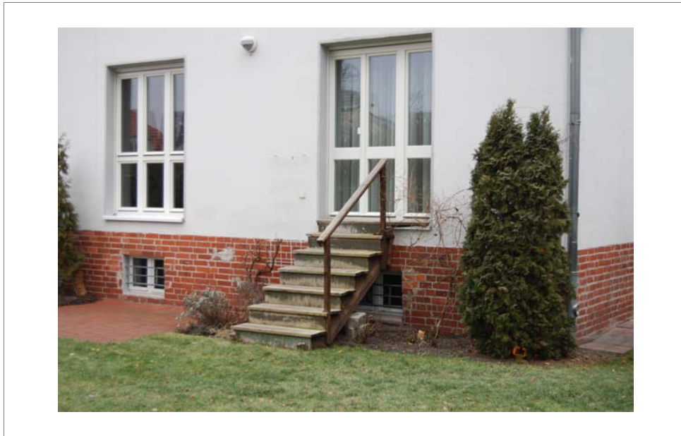
Treppe zum Garten vor dem Umbau
