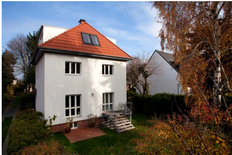
Vorderansicht nach dem Umbau
